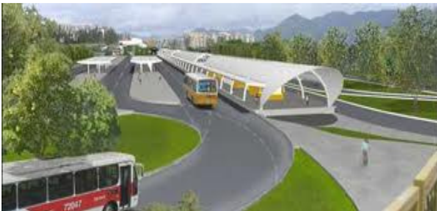
Ao lado, o projeto do Terminal de Integração do Magarça, do Corredor Transoeste e apesar da modernidade do mesmo, percebe-se nitidamente a falta de passarelas e mezanino para transposição dos passageiros entre as plataformas e tampouco sabe-se da existência de passagem subterrânea que permita essa circulação com maior segurança. A circulação de usuários por dentre os ônibus e pistas é nociva ao perfeito funcionamento do sistema e perigosa a manobra dos veículos. Por este tocante, percebe-se a falta de experiência dos projetistas no RJ para esse tipo de instalação. (foto: www.piniweb.com.br )
