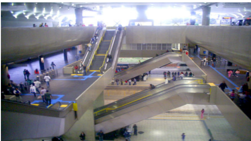
Em São Paulo, um bom exemplo de mobilidade em Terminal de Corredor Expresso. No exemplo ao lado, um dos terminais do Expresso Tiradentes de média velocidade com o ponto final dos ônibus expressos no andar superior, um mezanino central com serviços, wcs e outras facilidades e no andar inferior, o ponto final de ônibus municipais para onde os passageiros se transferem ao início ou final de cada viagem. (foto: www.desfazendonos.wordpress.com )
